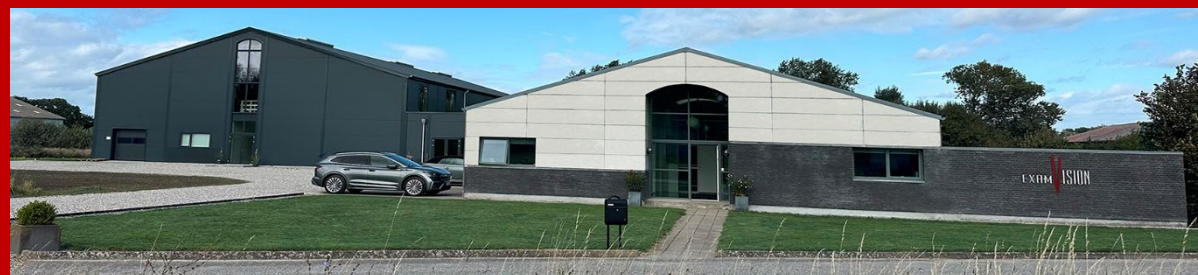
Vores hovedsæde på Industrivej 11, bygget i 2007, udvidet i 2013 og afslutte med 2 etage fabrik i 2024.
